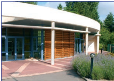
Crématorium du Mont-Valérien à Nanterre
