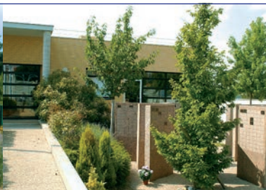
Crématorium du Val-de-Bièvre à Arcueil
